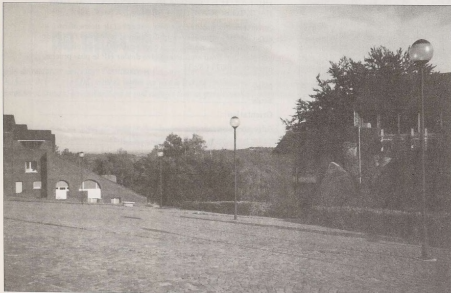
C'est là, entre les bâtiments de Psycho et de Droit, que de nouveaux amphithéâtres seront construits. Echéance: 1995. Si tout va bien...
